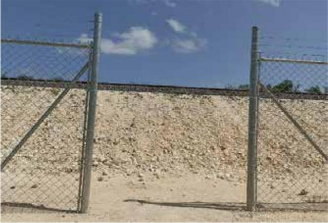
Mano de obra para confinamiento longitudinal de derecho de vía con postes a base de tres líneas de alambre de puas calibre 12.5 en varios kilometrajes aislados de la vía férrea del tren Maya en el estado de Campeche.
